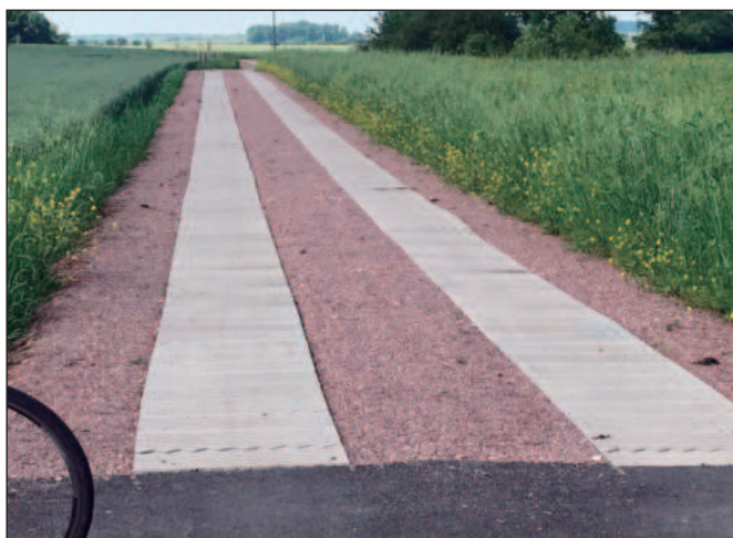
Obr. 19 Kolejová cesta HPC 4 a 5. Nejen únosný ale i propustný kryt vozovky. Také drény nahrazující příkopy zmenší zábor zemědělské půdy a eliminují náklady na údržbu cesty.
