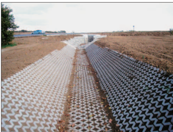
Obr. 16. Vybudovaný skluz kanálu betonovými zatravnňovacími tvárniciami
