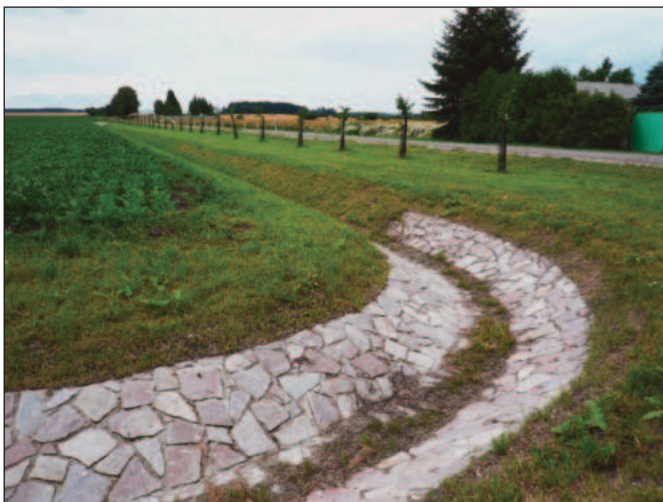
Obr. 6. a 7. Záchytný příkop po zatravnění a vysazení doprovodné zeleně (50 ks stromů a 360 ks keřů)
