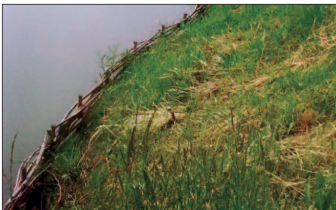
Obrázek č. 13 a 14 Důmyslný detail. Zpevnění břehů rybníka haťovým plůtkem z vrby
