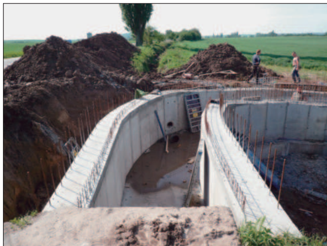
Obr. 13. a 14. Výstavba rozbočovacího objektu na začátku obtokového kanálu
