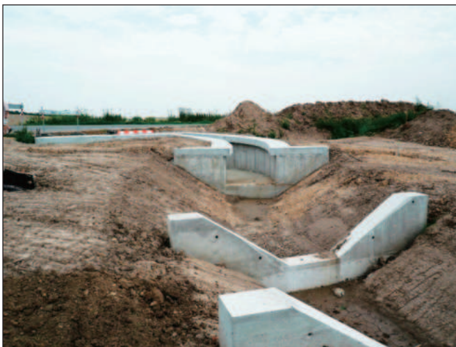
Obr. 13. a 14. Výstavba rozbočovacího objektu na začátku obtokového kanálu
