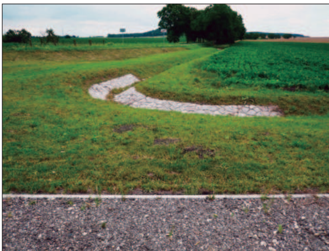
Obr. 6. a 7. Záchytný příkop po zatravnění a vysazení doprovodné zeleně (50 ks stromů a 360 ks keřů)
