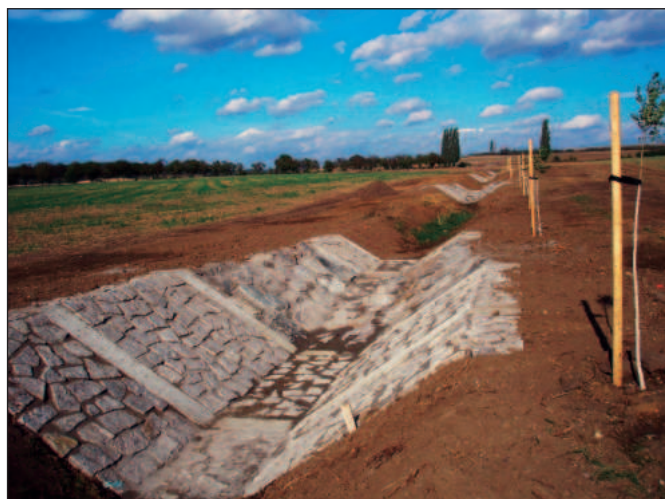
Obr. 15. Zpevnění břehů a dna prvního úseku obtokového kanálu
