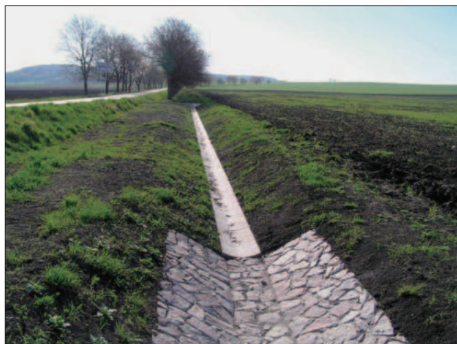
Obr. 4. Stav SO 1 – záchytného příkopu při kolaudaci
